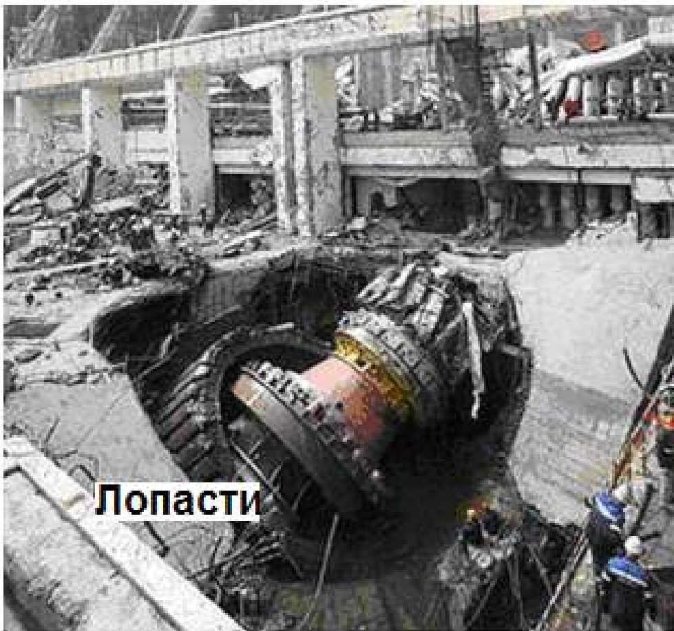
Рис. 189. Фото энергоблока и строительной колонны, стёсанной вращавшимся энергоблоком
