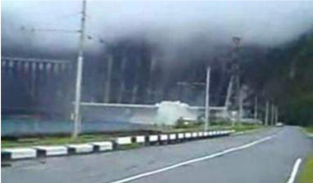
Рис. 188. Профиль фонтана воды в момент взрыва энергоблока
