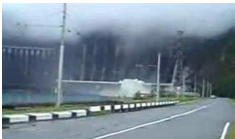
Рис. 118. Профиль фонтана воды в момент взрыва в колодце второго энергоблока
